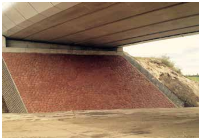
Kantzuilen bij viaduct A1 - A6.
