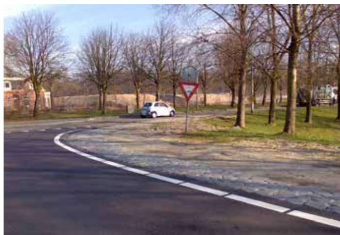
Betonnen Kantzuilen als rammelstrook.
