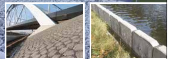
Met betongranulaat als (deel) grindvanger
