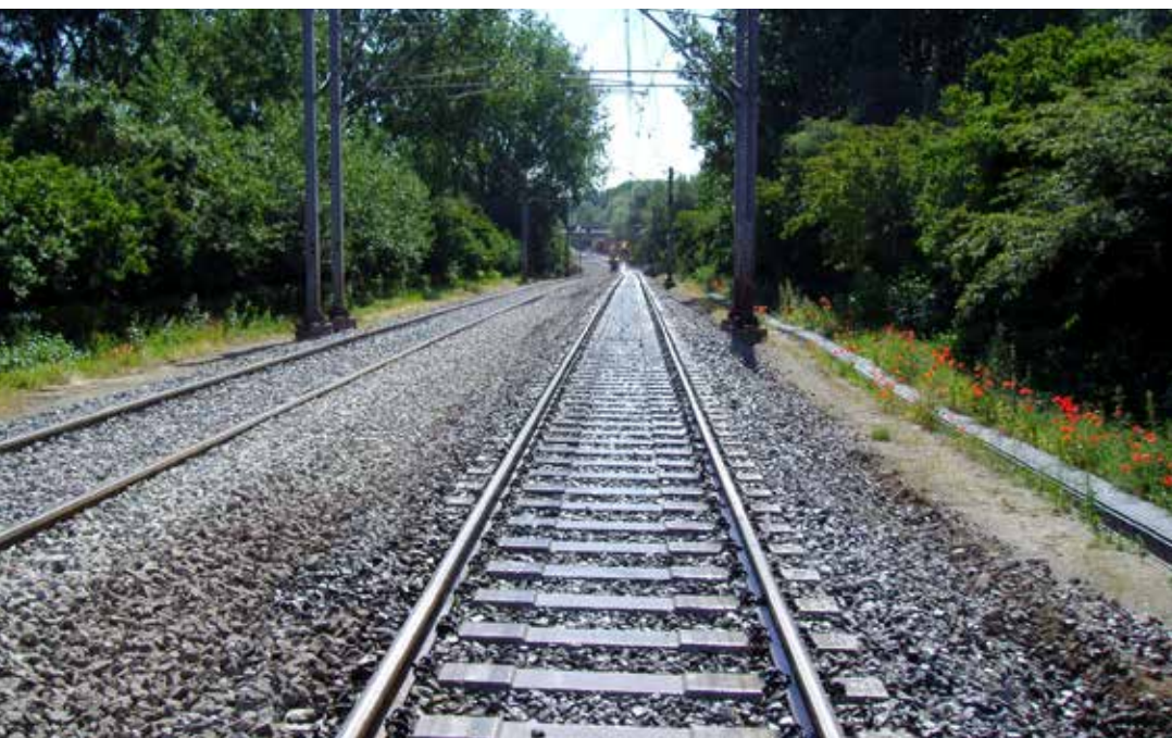
De Solo-bloc® dwarsligger is vanwege het dry cast productieproces relatief goedkoop, flexibel en robuust voor Lightrail, Tram en Metro. Zoals hier bij project RandstadRail.
