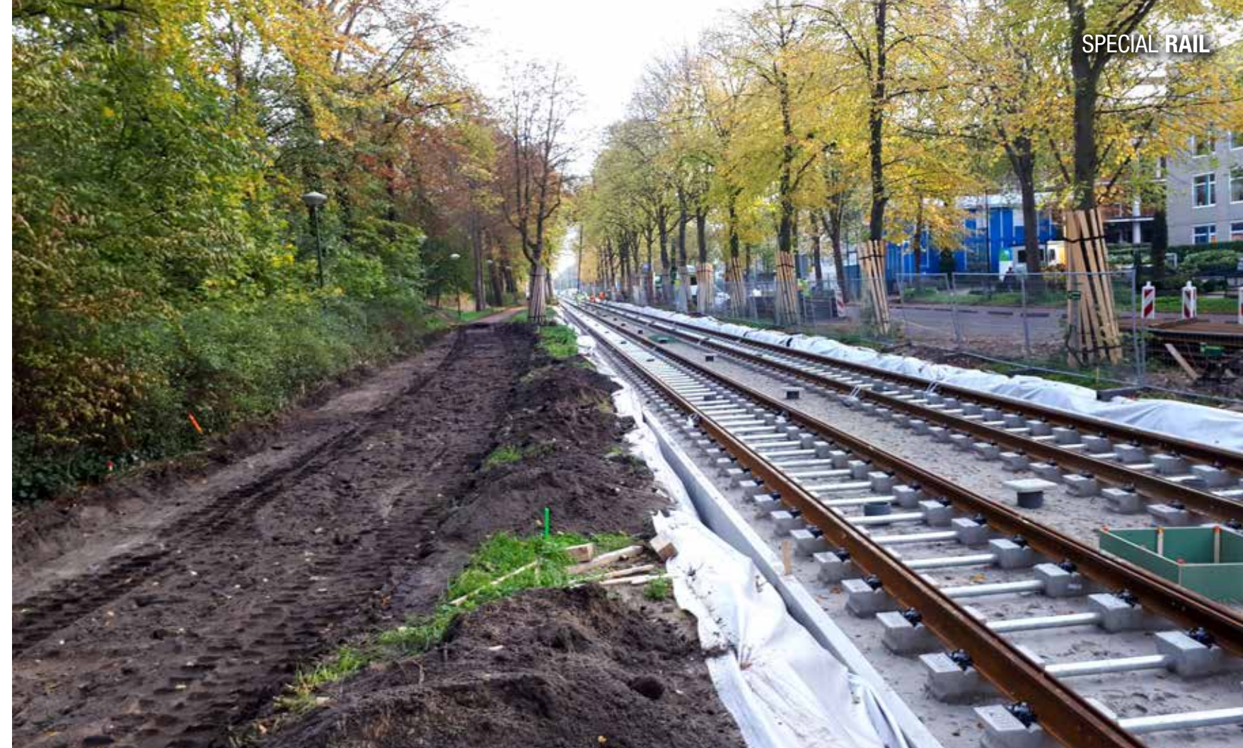
De Duo-bloc-buis dwarsliggers worden toegepast in asfalt/beton gesloten baanconstructie voor Lightrail en Tramlijnen. Zoals hier bij een project in Scheveningen.
